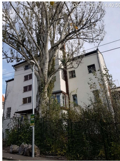
utcai homlokzat felől
