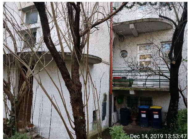
előkert felőli homlokzatrész
