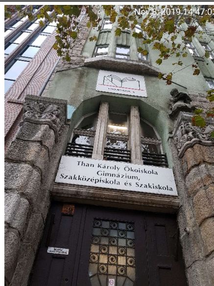
Duna felőli homlokzat
