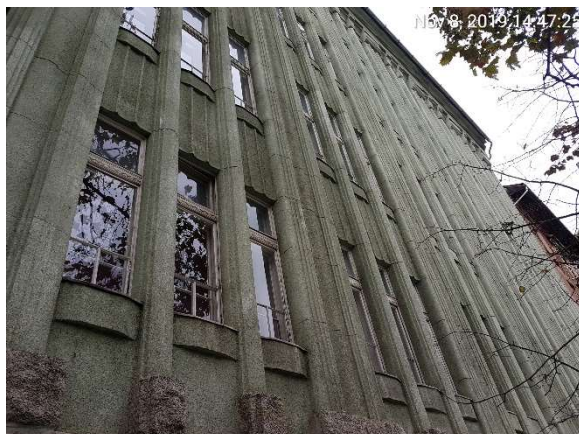
Duna felőli homlokzat
