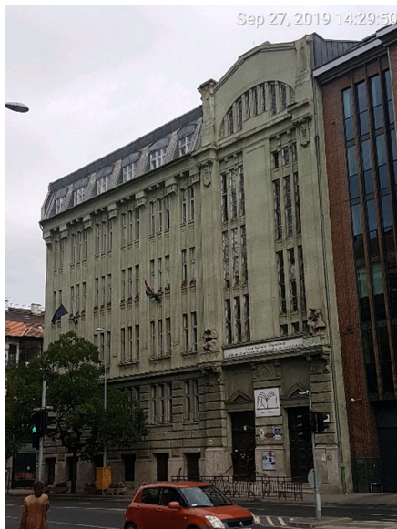
utcai homlokzat felől
