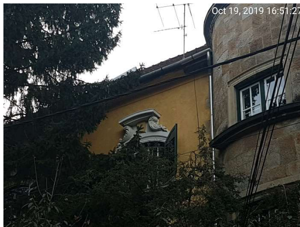
Kuruc utcai homlokzat
