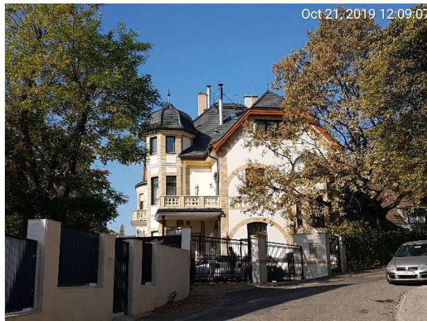
utcai homlokzat felől
