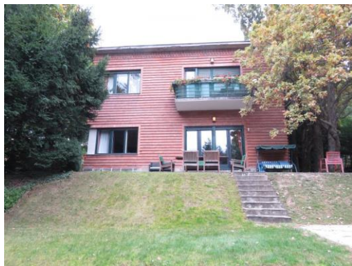
Erkélyes homlokzat és a teraszos kiképzésű terep
