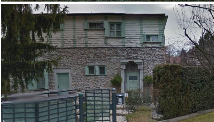
Ellák utca felőli homlokzat
