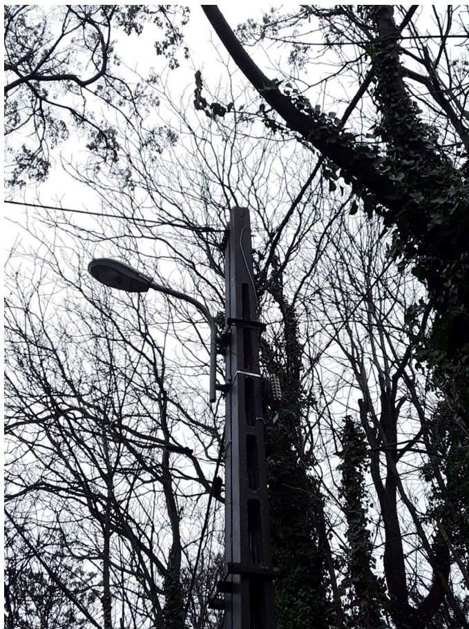
3. ábra Közműoszlop, közvilágítás és légvezeték a koronában
