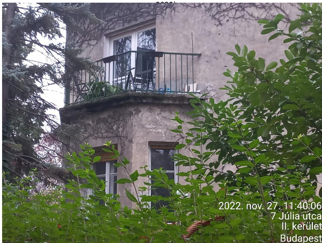
Emeleti ráépítés az erkély szintje, alatti eredeti kiosztású ablakok (Saját felvétel, 2022)
