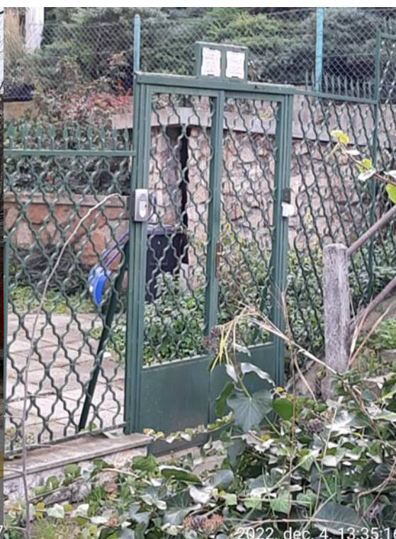
Kerítés részlet bejárat kapu
