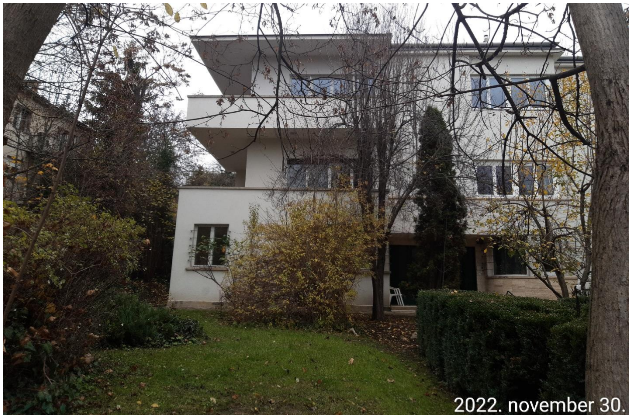
Az épület homlokzata
