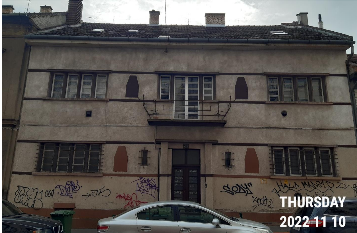
A Retek utca 32. száma alatti épület főhomlokzata
