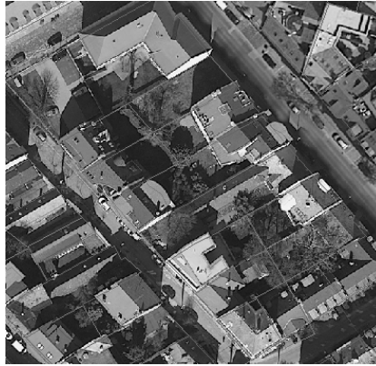
klasszikus keretes beépítésű tömb az Ürömi utca és a Daru utca között
