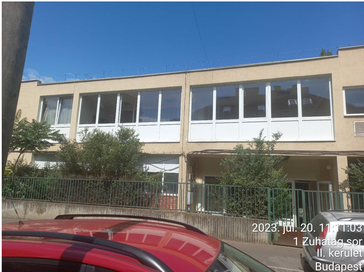
Kiszolgáló épületek a Pénzügyőr SE sporttelep telkén a Zuhatag sor felől, Saját fotó, 2023
