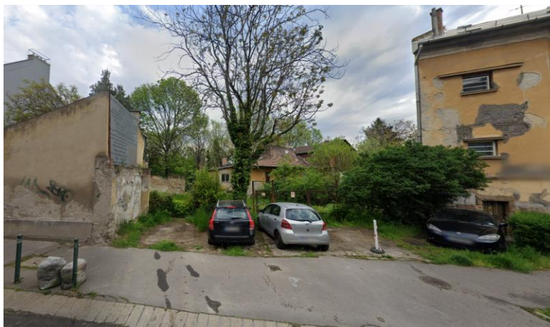
10 Ürömi utca 21., illetve a szomszédos épületek (Ürömi utca 23. és 19.)
