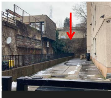
A bejáró területébe benyúló épületrészek és magas hátsó támfal együttes képe
