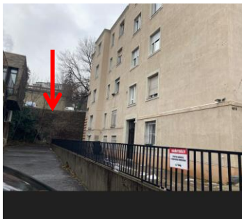
A jelenlegi gépjárműves bejáró és végén a magas támfal
